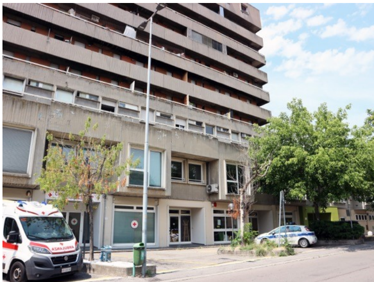
Figura 2: L'edificio R-Nord, sede di Makers Modena
